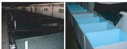
Hình 8 & 9: Các bể nuôi vỗ tôm bố mẹ được phủ sơn Epoxy
