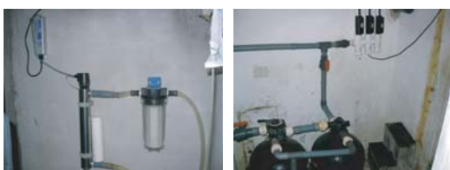
Hình 22 & 23: Hệ thống siêu lọc và đèn cực tím dùng cho bể đẻ và bể ấp.
